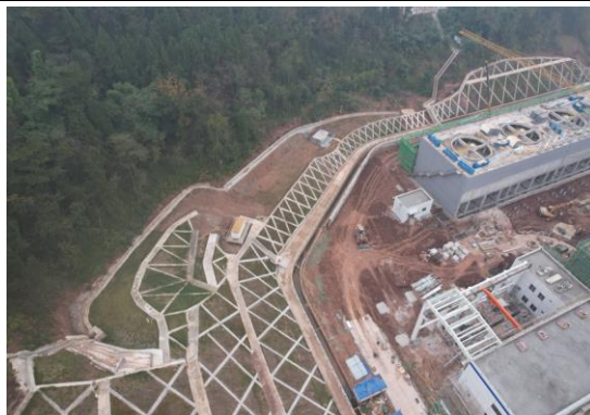
浆砌片石骨架护坡
