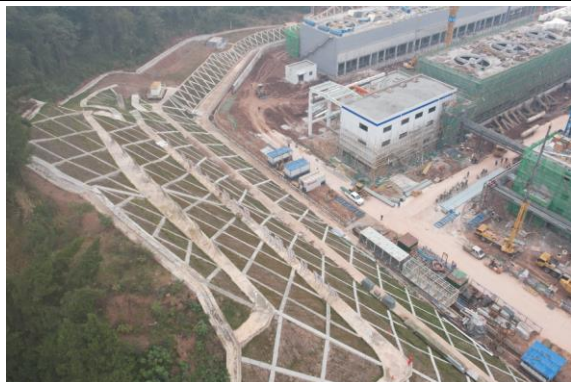
浆砌片石骨架护坡
