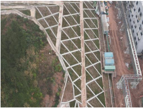
图3.1-3 浆砌片石骨架铺草皮护坡（骨架）
