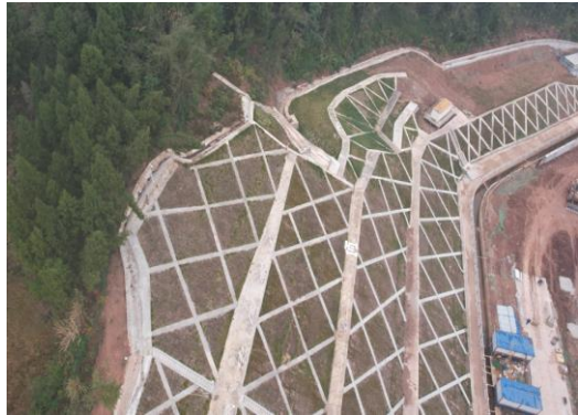
图3.1-3 浆砌片石骨架铺草皮护坡（骨架）
