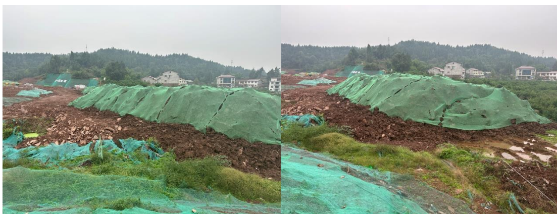
图 1.1-5 表土临时堆放场区施工现状
