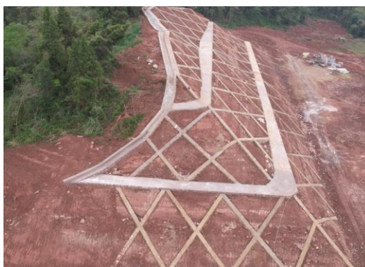
图3.1-3 浆砌片石骨架铺草皮护坡（骨架）
