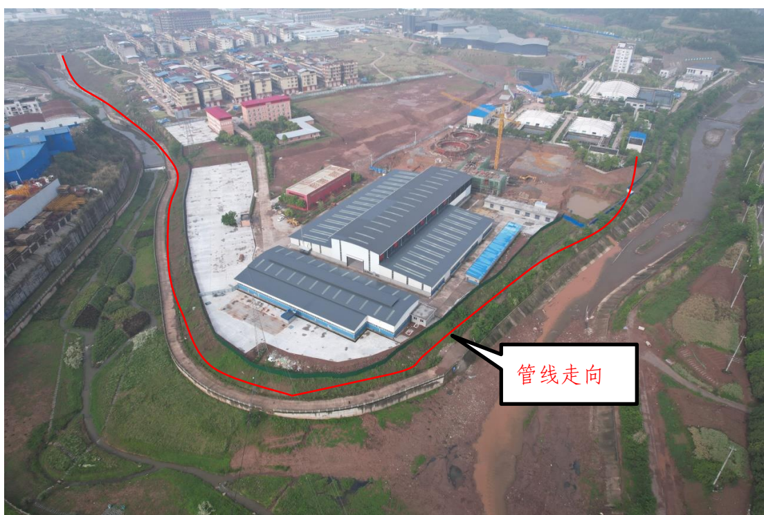
图 1.1-3 取水管线工程区施工现状
