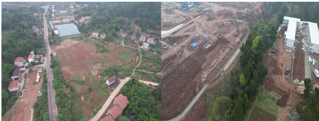
图 1.1 -4 施工生产生活设施区现状
