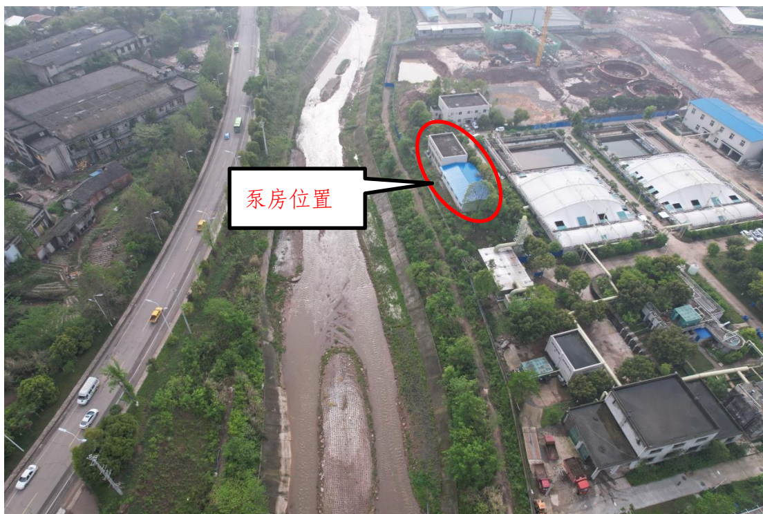
图 1.1-2 取水泵房工程区施工现状
