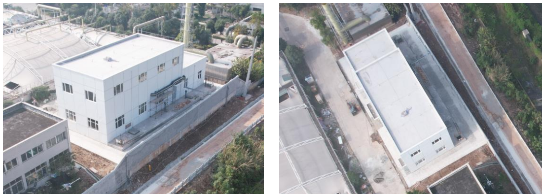
图1-2 取水泵房扰动现状
