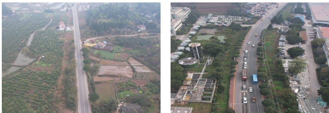
图1-3 取水管线工程区现状
