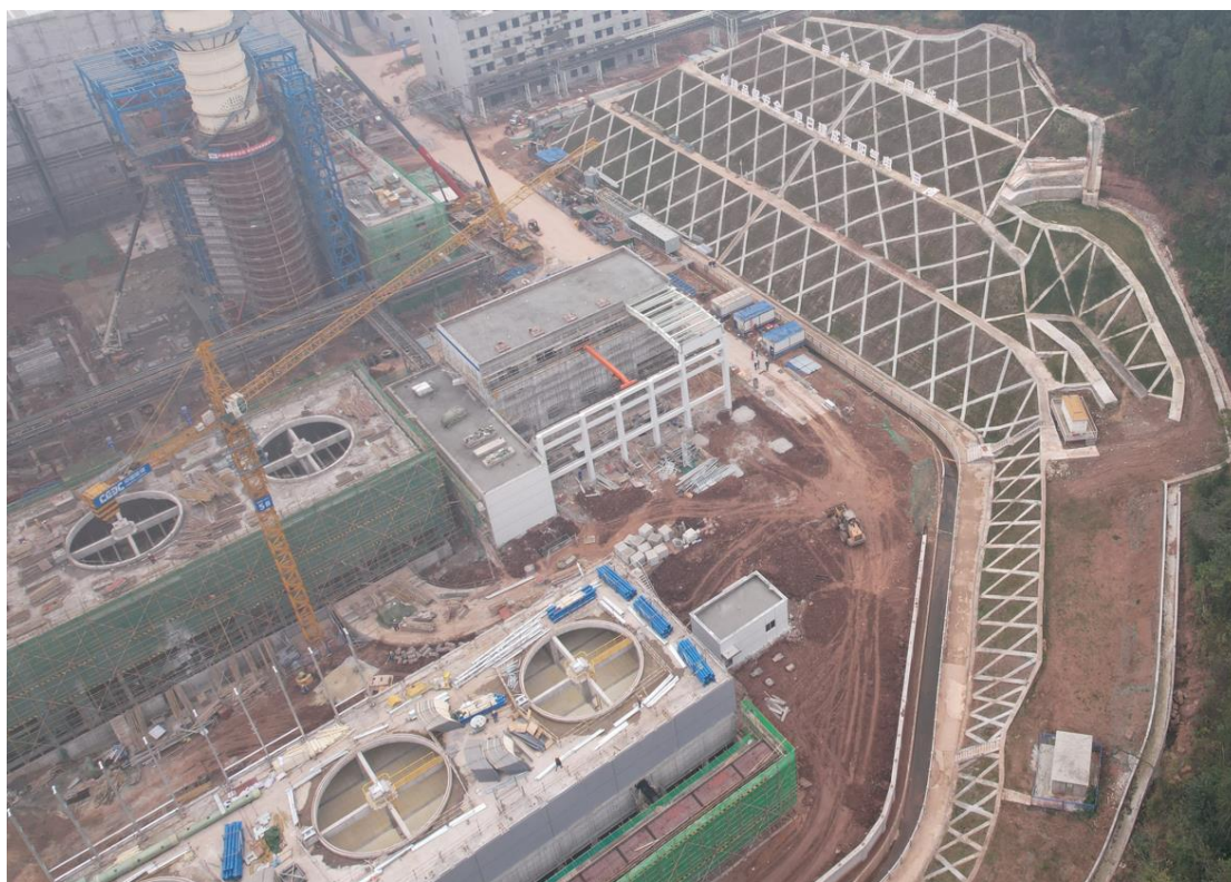
图1-5 表土临时堆放场区现状
