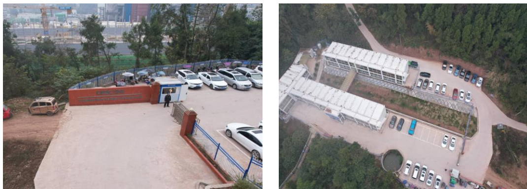
图1-4 施工生产生活设施现状
