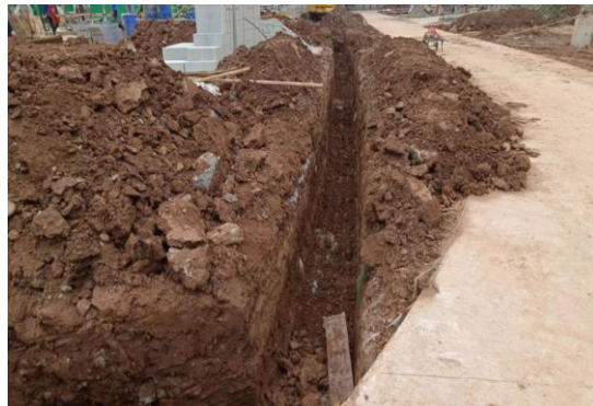
图1-1 厂区施工情况
