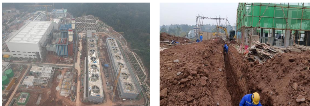
图1-1 厂区施工情况
