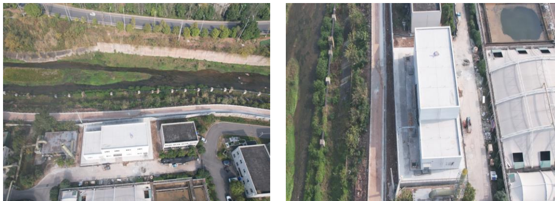
图1-2 取水泵房扰动现状
