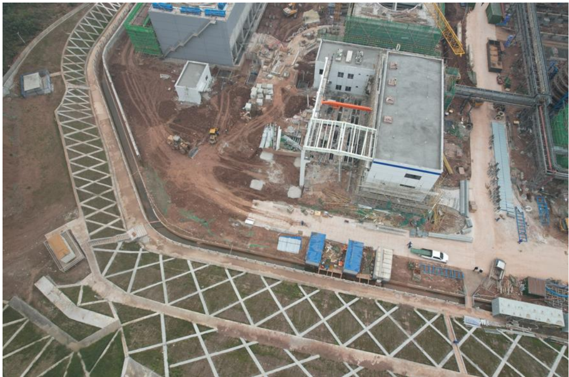
图1-5 表土临时堆放场区现状
