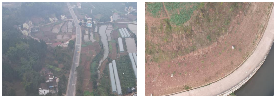
图1-3 取水管线工程区现状
