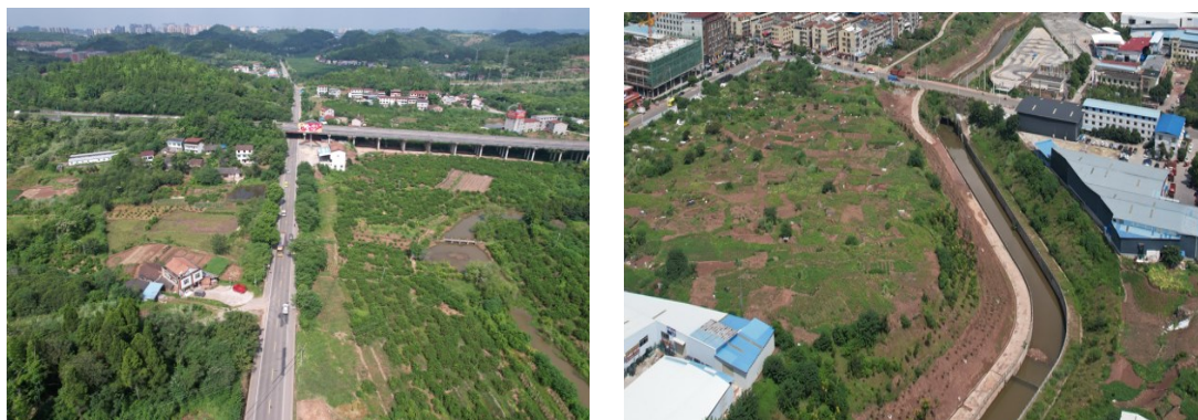
图1-3 取水管线工程区现状
