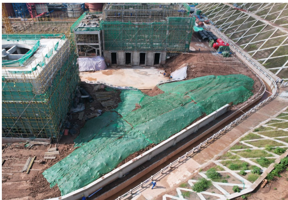
图1-5 表土临时堆放场区现状
