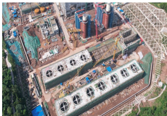
图1-1 厂区施工情况
