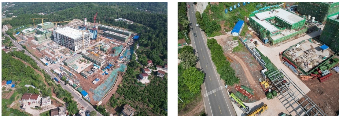
图1-1 厂区施工情况
