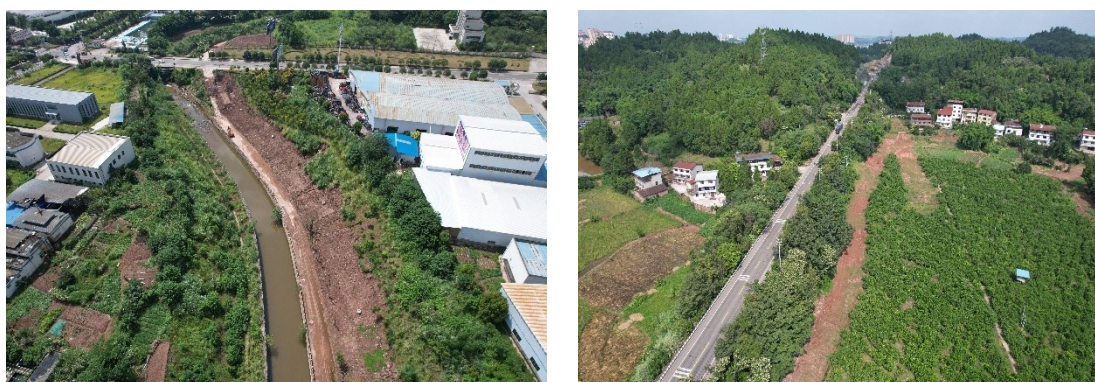
图1-3 取水管线工程区现状
