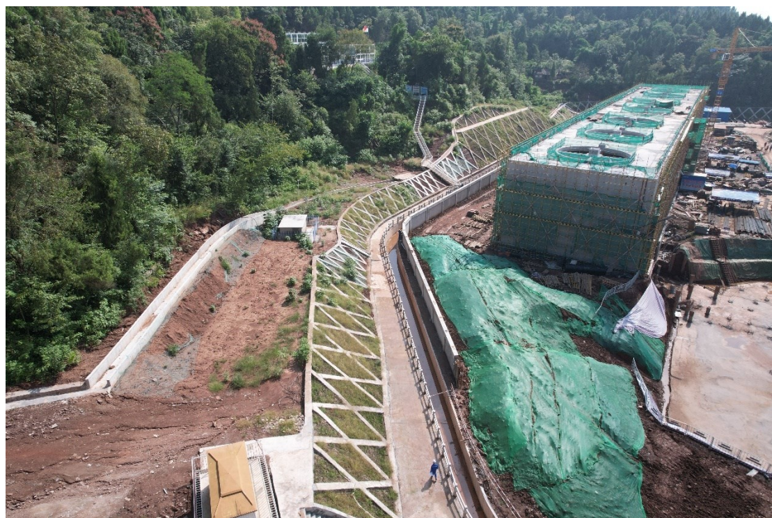
图1-5 表土临时堆放场区现状
