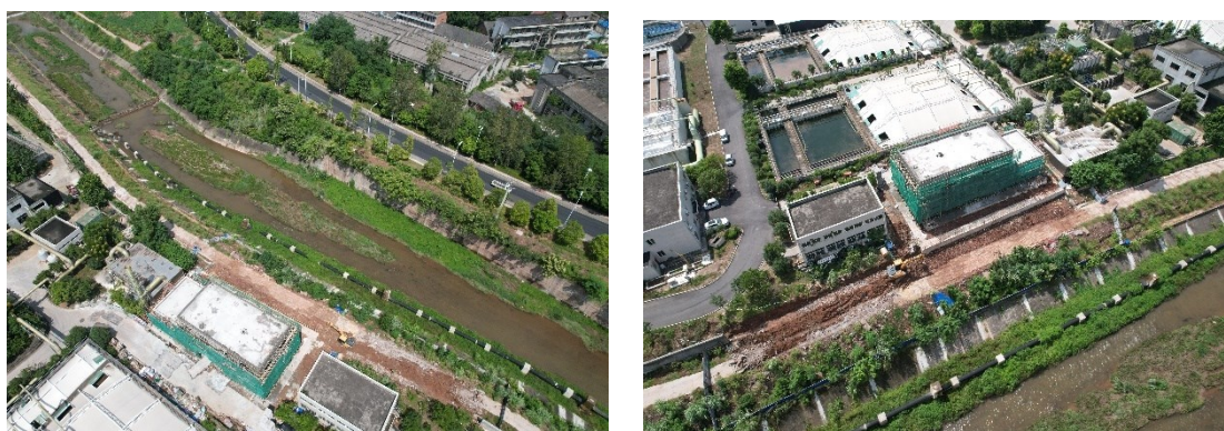
图1-2 取水泵房扰动现状
