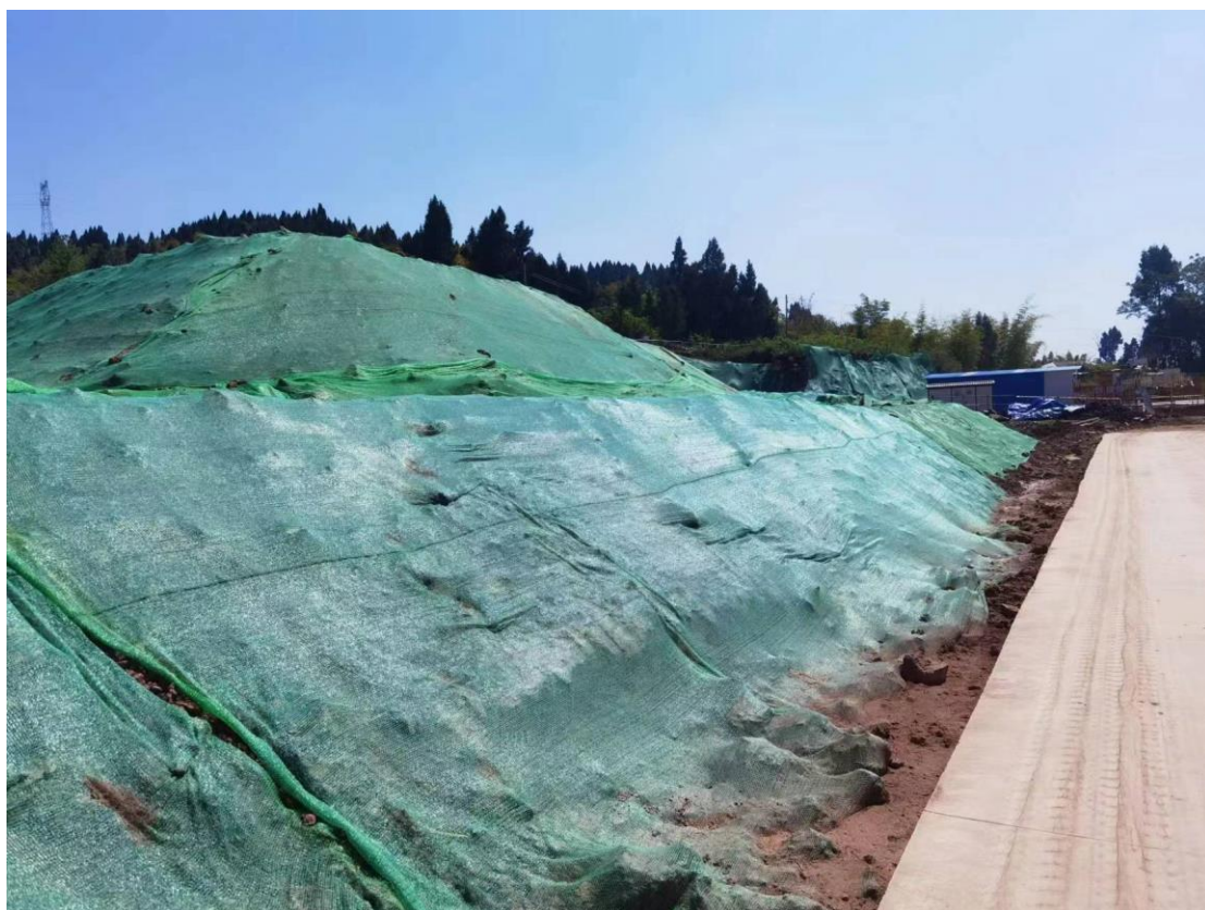
图1-12 表土临时堆放场区现状
