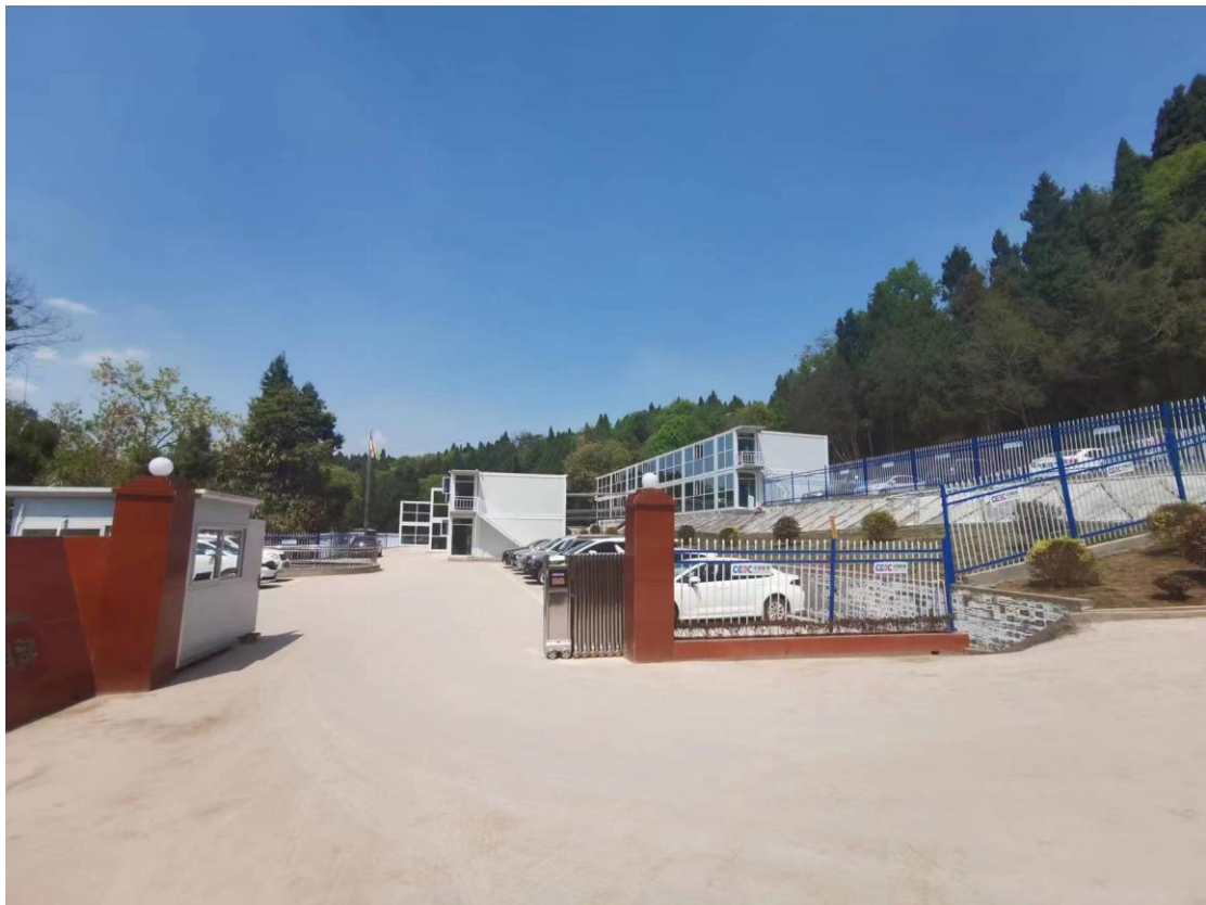
图1-11 施工生产生活设施现状
