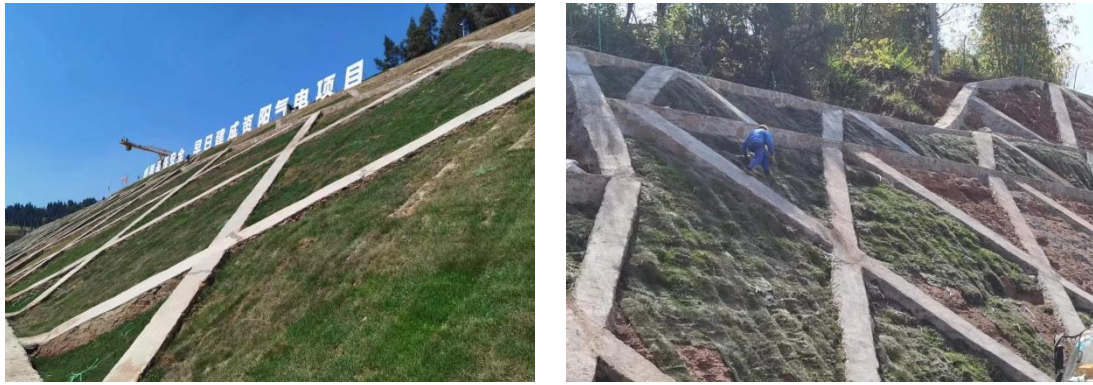
图1-7 边坡浆砌石护坡施工情况
