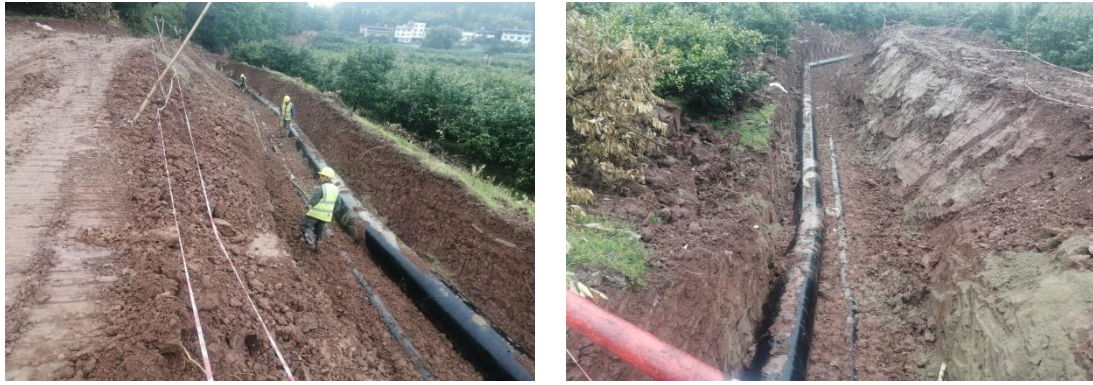
图1-10 取水管线工程区现状
