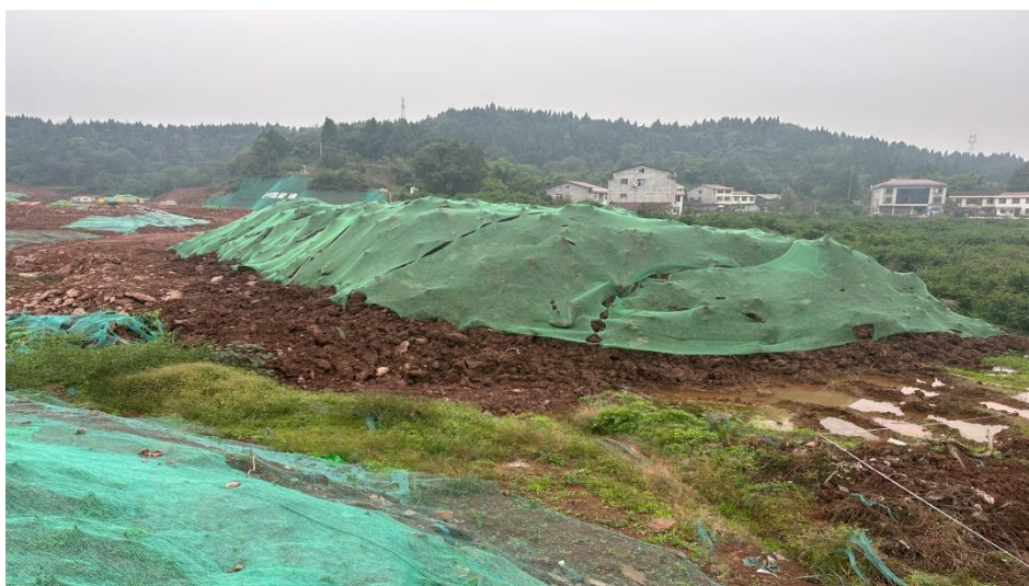
图1-12 表土临时堆放场区现状
