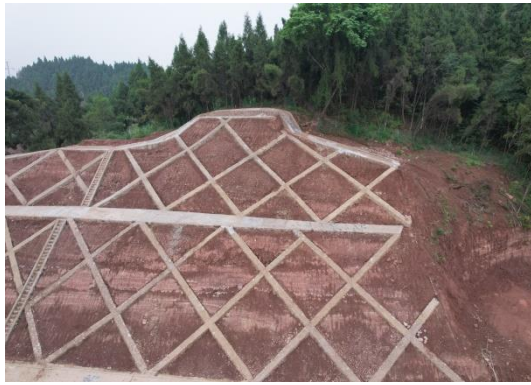
图1-7 边坡浆砌石护坡施工情况
