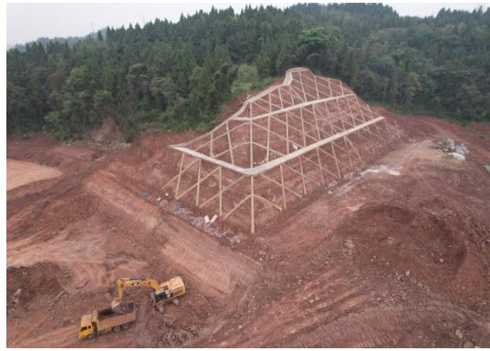
图1-7 边坡浆砌石护坡施工情况
