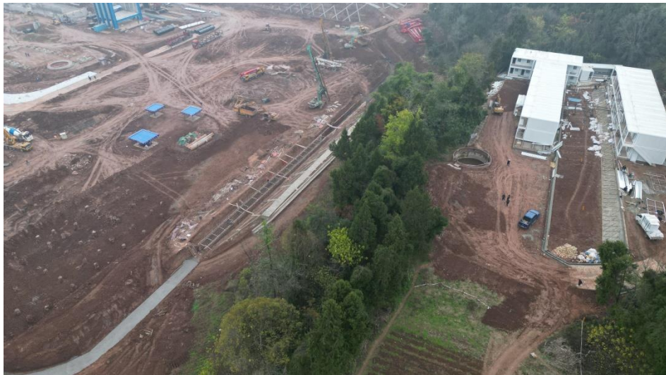
图1-11 施工生产生活设施现状
