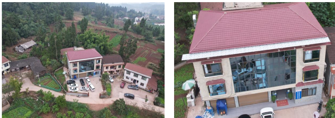
图2-1 现场施工营地及施工项目部(工程部)
