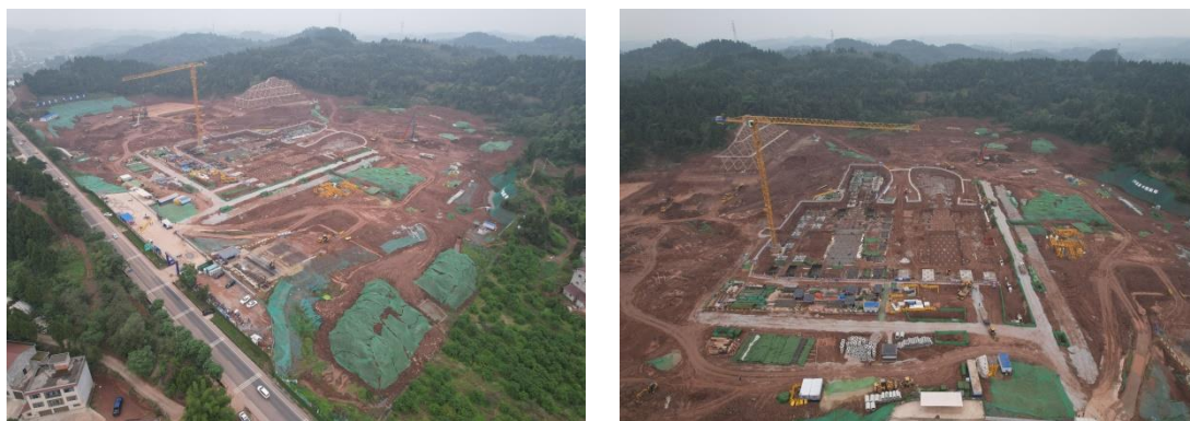
图1-6 厂区施工情况（已完成场平）
