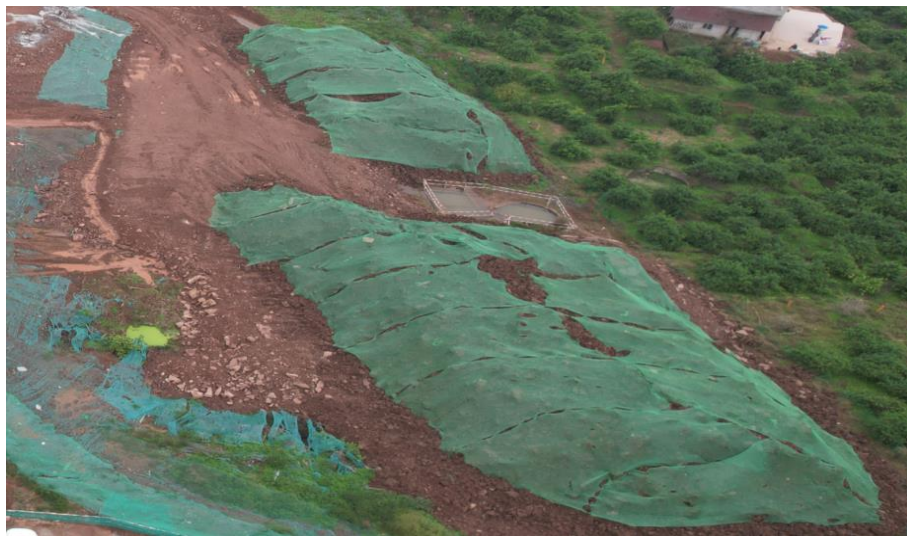
图1-12 表土临时堆放场区现状
