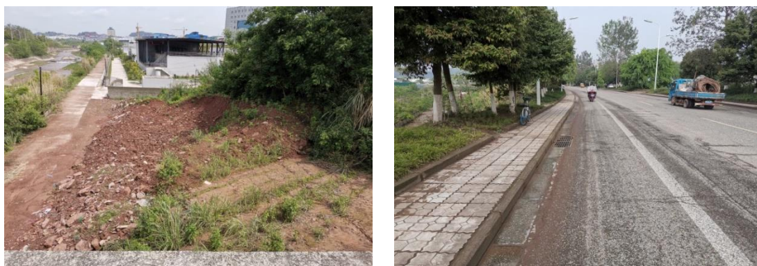
图1-10 取水管线工程区现状
