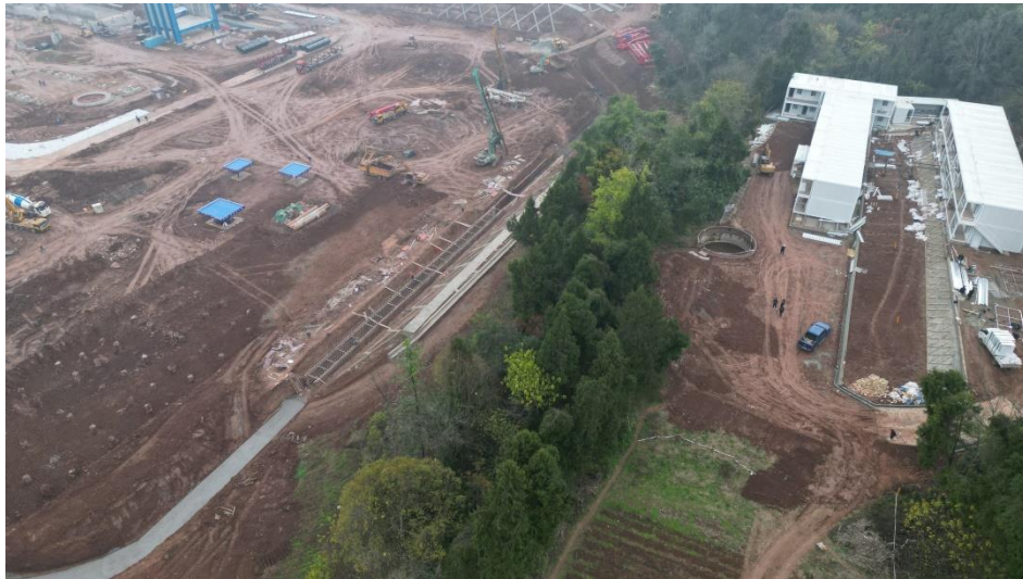
图1-11 施工生产生活设施现状
