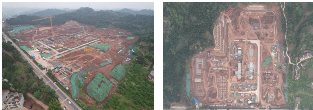
图1-6 厂区施工情况（已完成场平）
