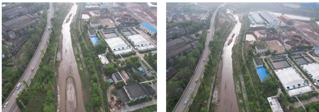
图1-9 取水泵房扰动现状
