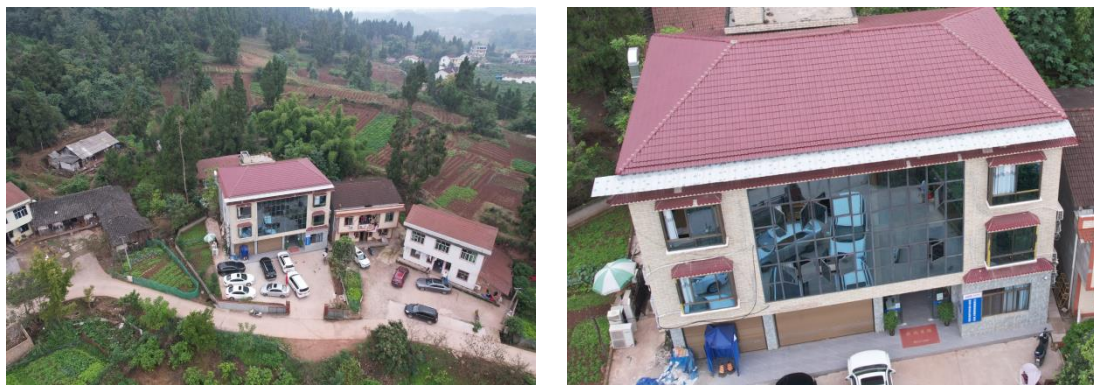
图2-1 现场施工营地及施工项目部(工程部)
