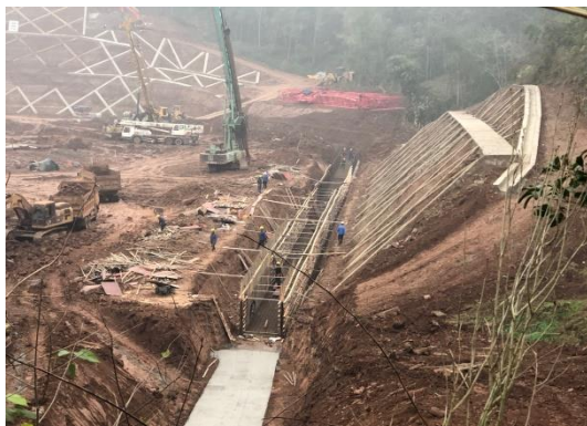
图1-7 边坡浆砌石护坡施工情况
