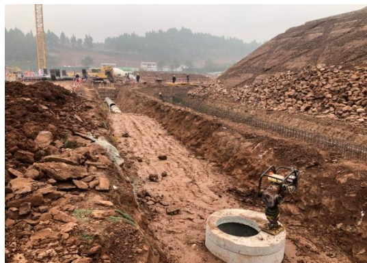
图1-7 边坡浆砌石护坡施工情况
