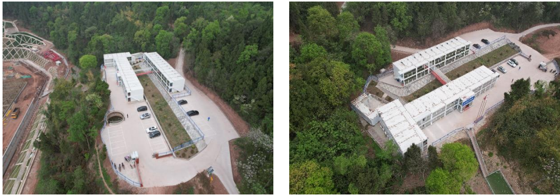
图1-11 施工生产生活设施现状
