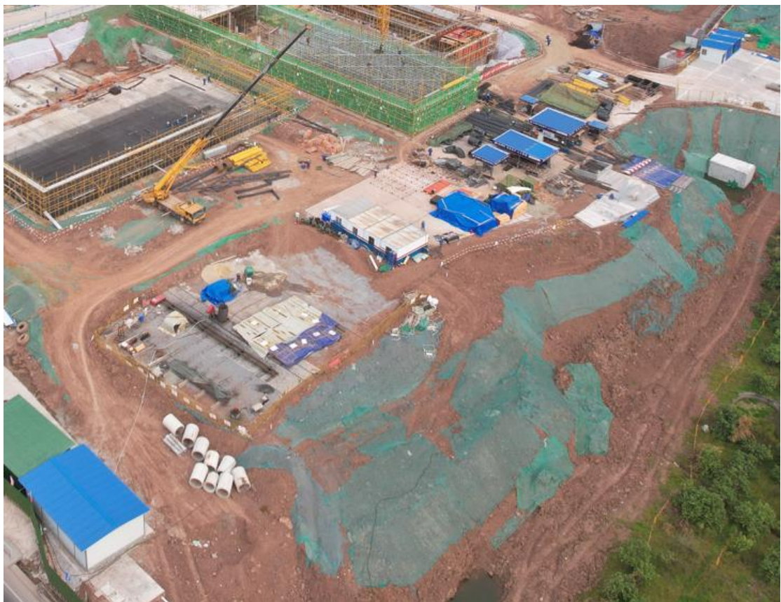
图1-12 表土临时堆放场区现状
