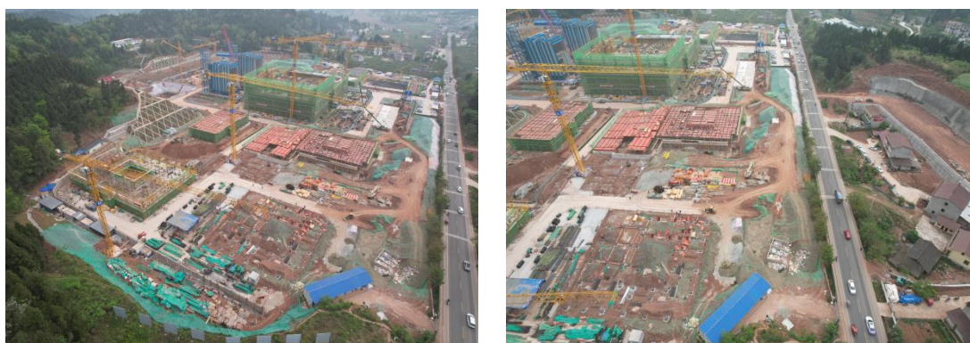
图1-1 厂区施工情况
