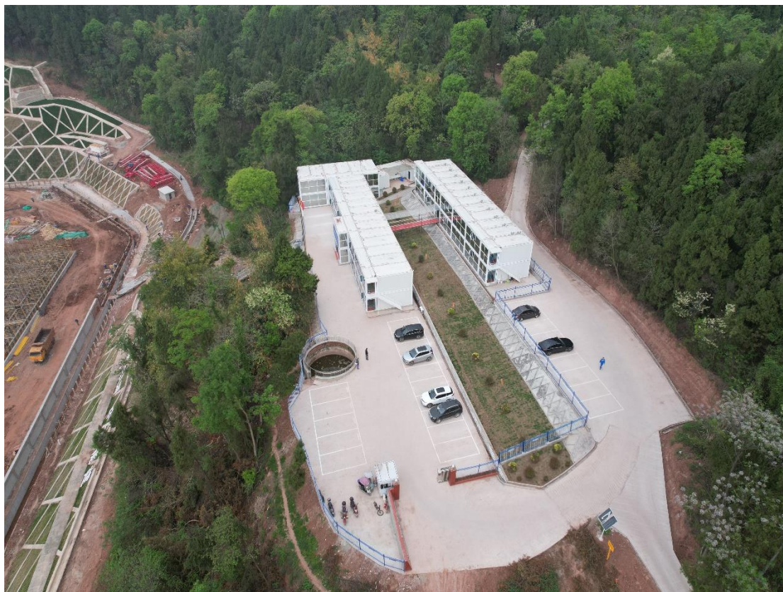
图2-1 现场施工营地及施工项目部(工程部)
