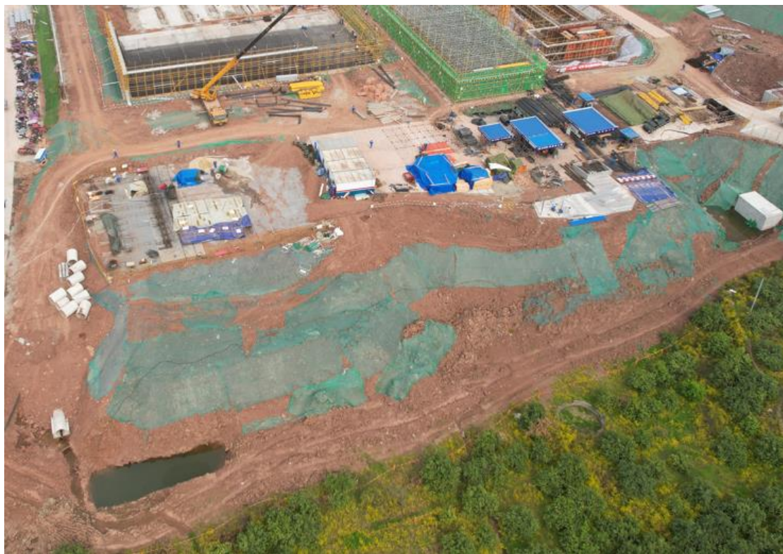
图1-6 表土临时堆放场区现状
