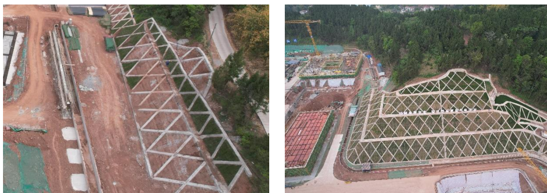
图1-7 边坡浆砌石护坡施工情况
